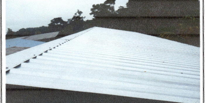
Foto 4: MODULO 2 AULAS Sustitución de lámina, por lámina troquelada aluzinc calibre 26
