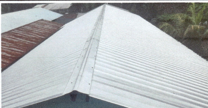
Foto 5: MODULO 2 AULAS Sustitución de capote de lámina para lámina troquelada
