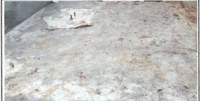
Foto 6: MODULO 2 AULAS Sustitución de fosa séptica
