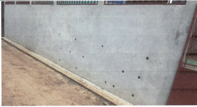
Foto1: MODULO 1 MURO Reparación de muro perimetral de block con soleras intermedias y columnas
