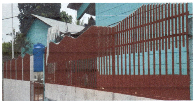
Foto 3: MODULO 1 MURO Fabricación e instalación de rejas de 18.30 x 1.00 mts.
